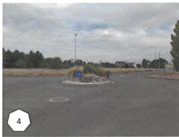
Vue sur le site depuis le giratoire
